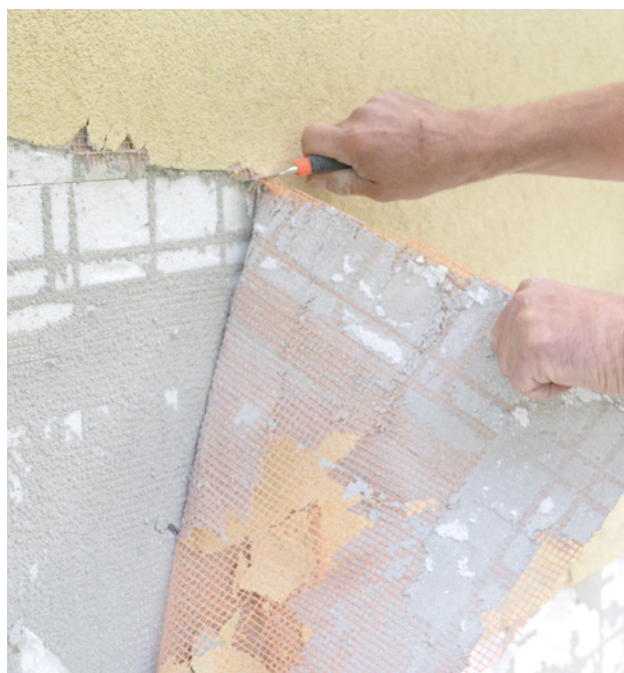
Viene rimossa la rete porta intonaco.
