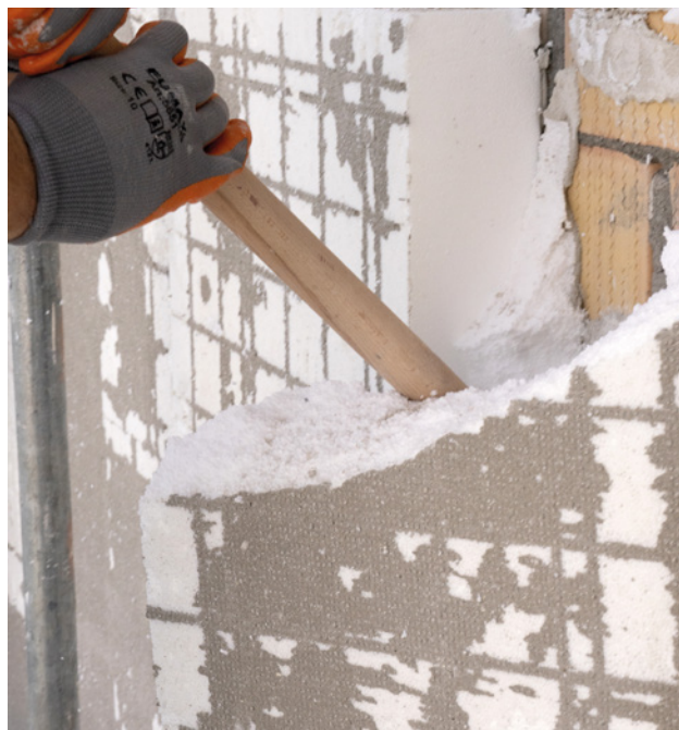
Il vecchio isolante in EPS viene rimosso manualmente.
