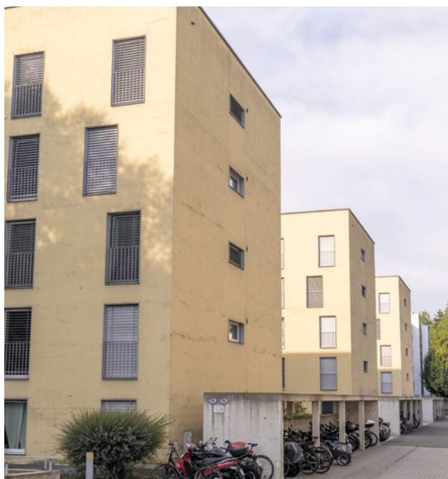
Singole parti delle facciate del complesso residenziale di Lucerna presentano danni.
